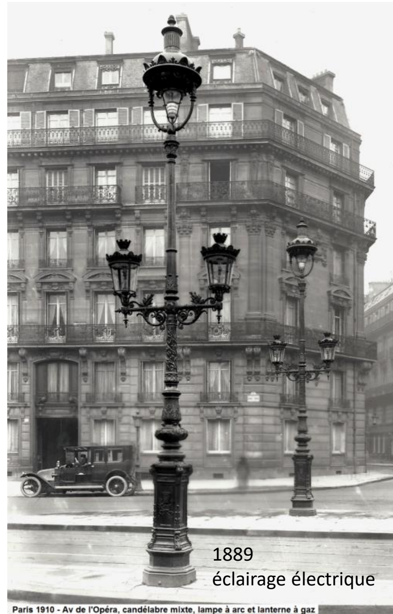
Paris 1910 - Av de l'Opéra, candélabre mixte, lampe à arc et lanterne à gaz
