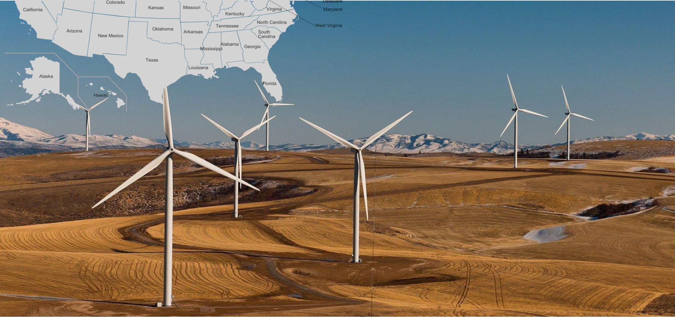
Parc éolien de 200 mégawatts (MW) dans l'État du Minnesota aux États-Unis.
